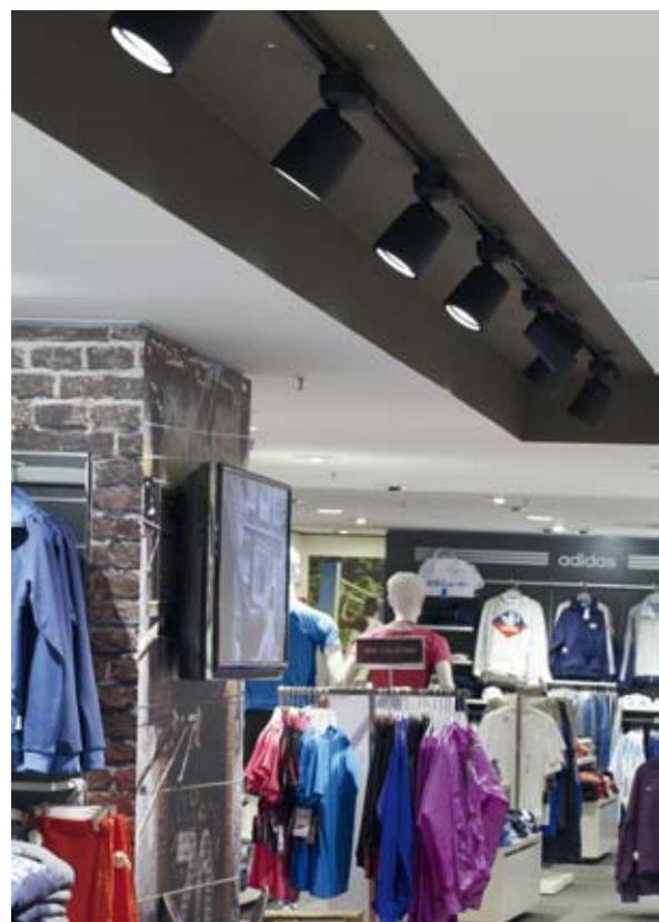
maximal 40 W Systemleistung bei 3-300 Lm Lichtleistung sowie eine Farbtemperatur von 3.000 K und einen Farbwiedergabe-Index größer RA 85 aufweist.
